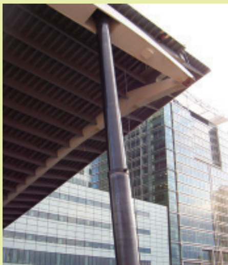
Teilansicht der geöffneten Brücke mit Ceraplate 2000 beschichteten Zylinderstufen
